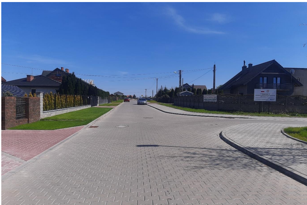
Wybudowany odcinek ul. 11 Listopada, od ul. Dworskiej do ul. Żwirki
