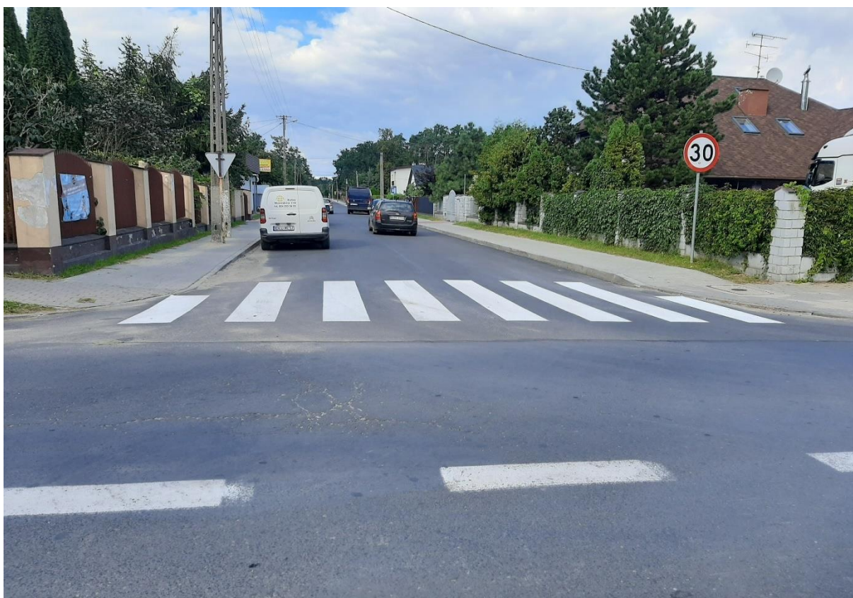
Wyremontowany odcinek ul. Skokowskiego
