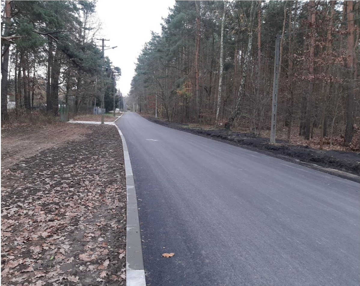
Wybudowany odcinek ul. Wyspiańskiego
