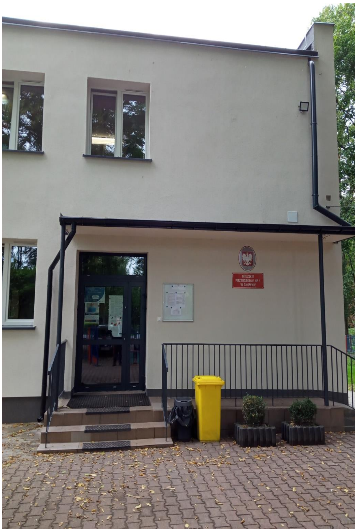
Obiekt po robotach termomodernizacyjnych – wejście od strony ul. Wigury
