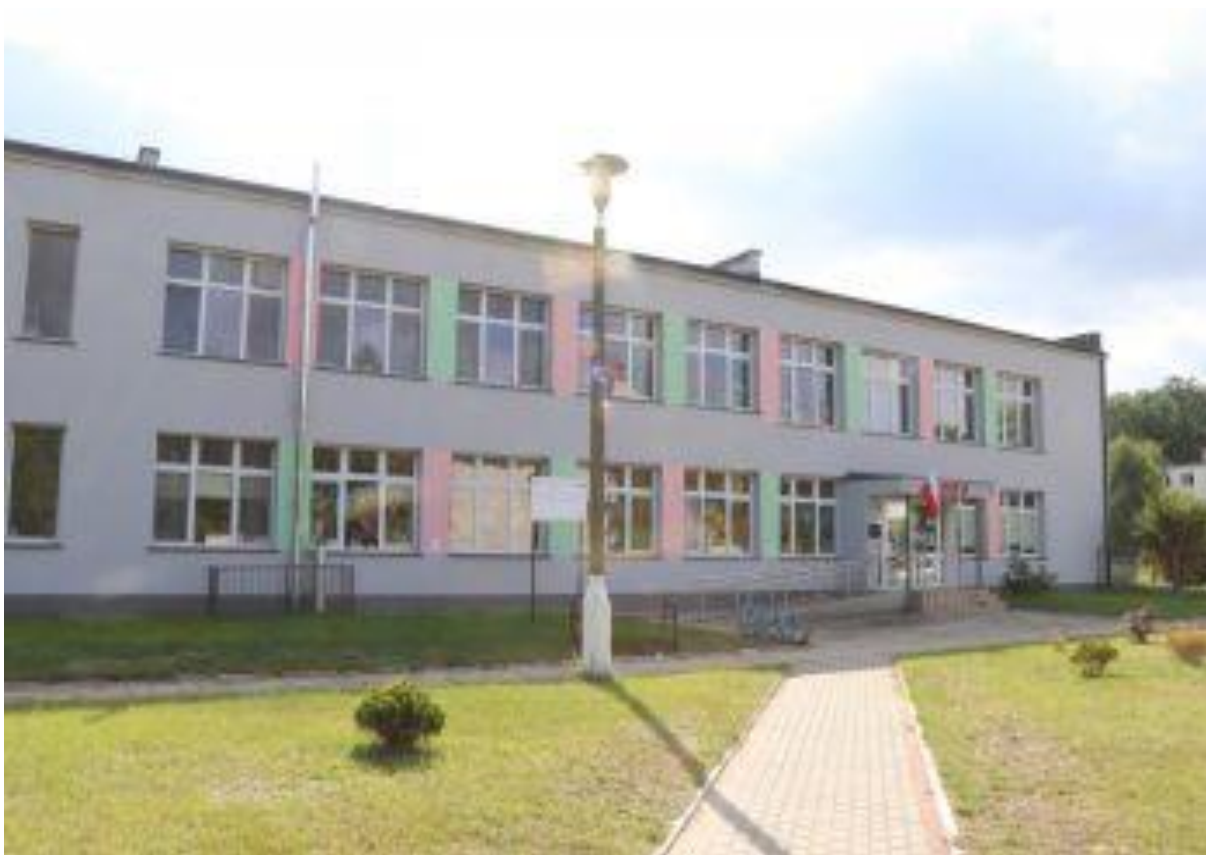
Widok budynku po robotach termomodernizacyjnych
