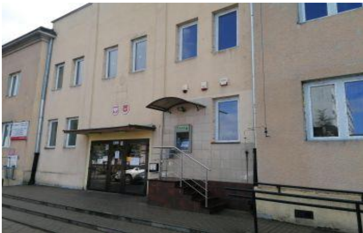
Widok budynku przed robotami termomodernizacyjnymi
