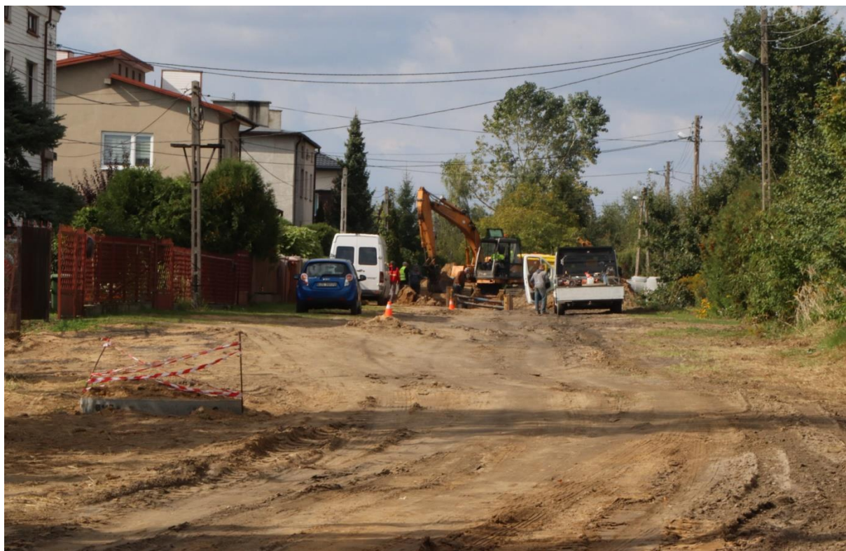
Początek robót, wrzesień 2021 r.
