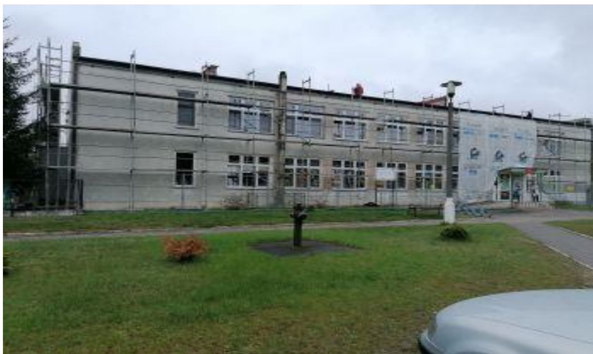
Widok budynku w trakcie robót termomodernizacyjnych
