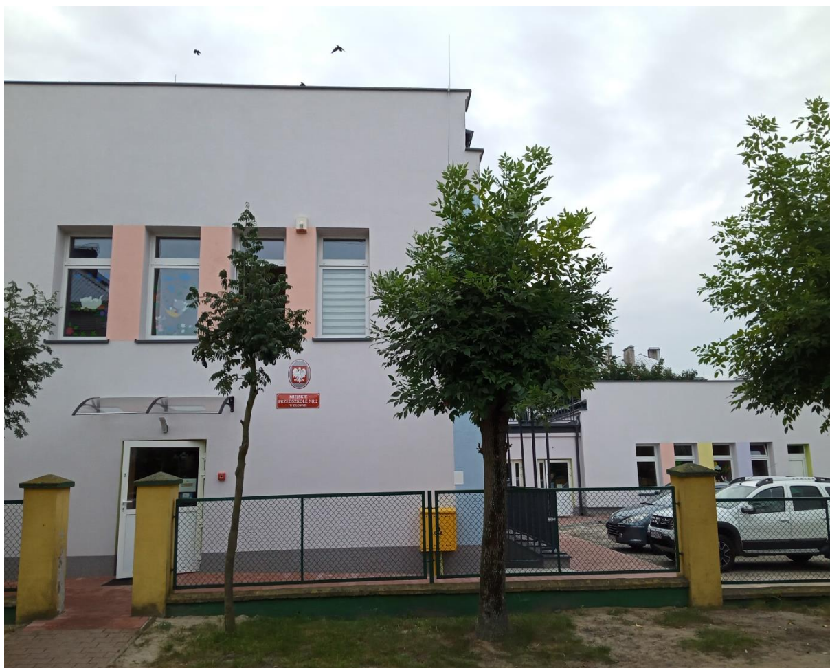
Widok budynku po robotach termomodernizacyjnych
