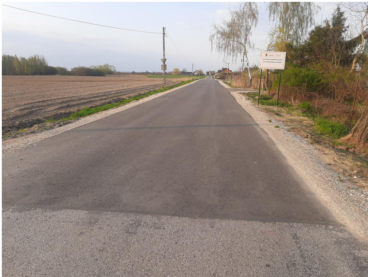
ul. Wiejska po realizacji robót
