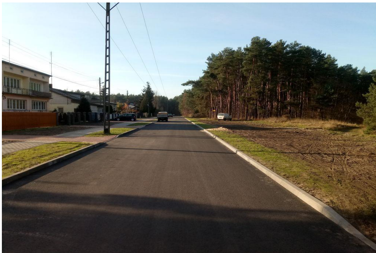
ul. Ułańska – widok przed budową ścieżki rowerowej
