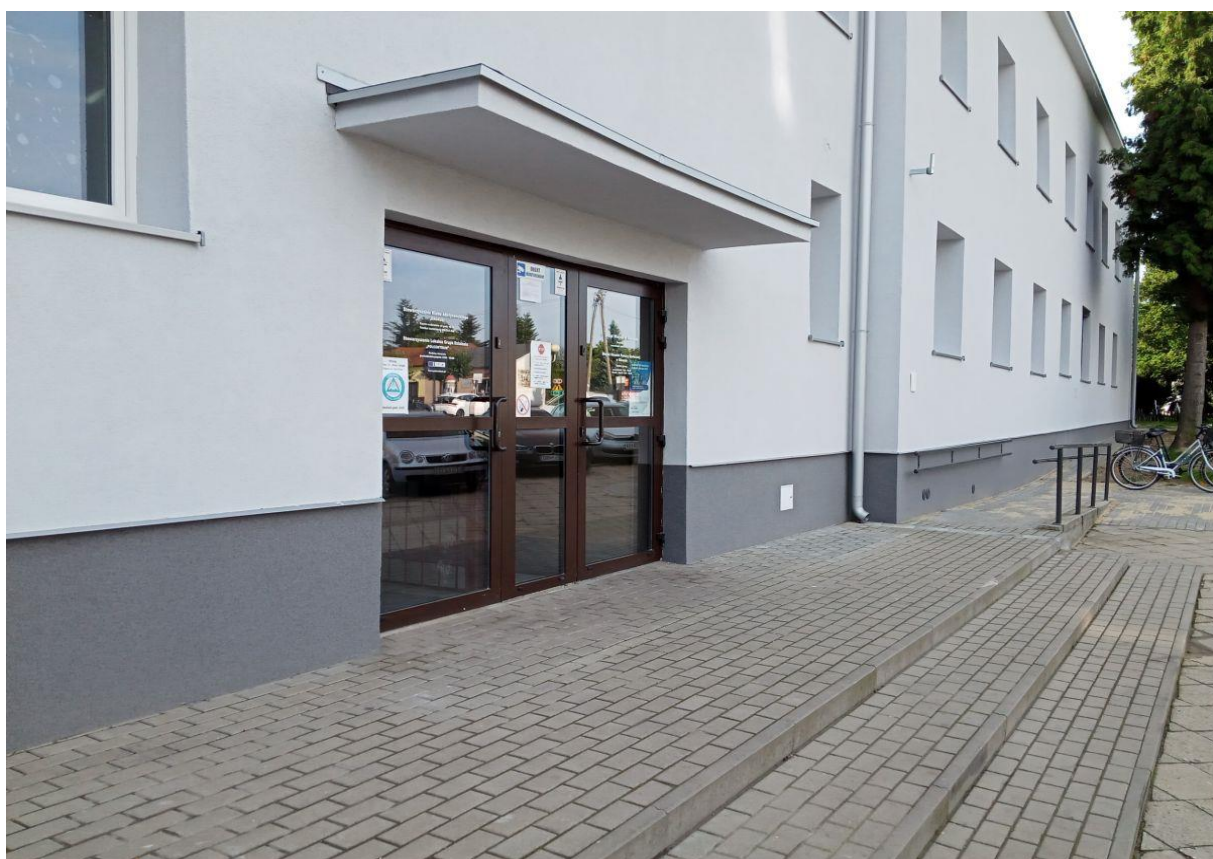
Widok budynku po robotach termomodernizacyjnych
